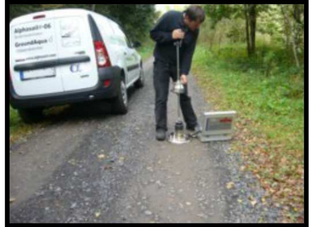
Проверка несущей способности лесохозяйственной дороги в Германии
