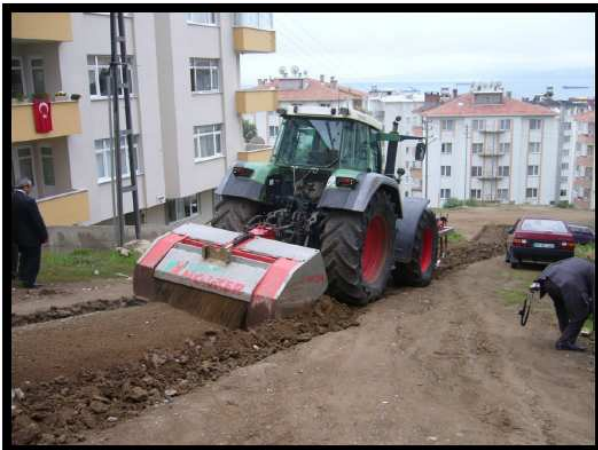
Ремонт дороги на Черном море
